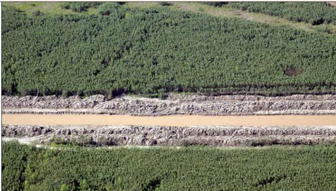
Área forestal que sirve de contención para evitar que el torrente del río ingrese en los campos sembrados.
